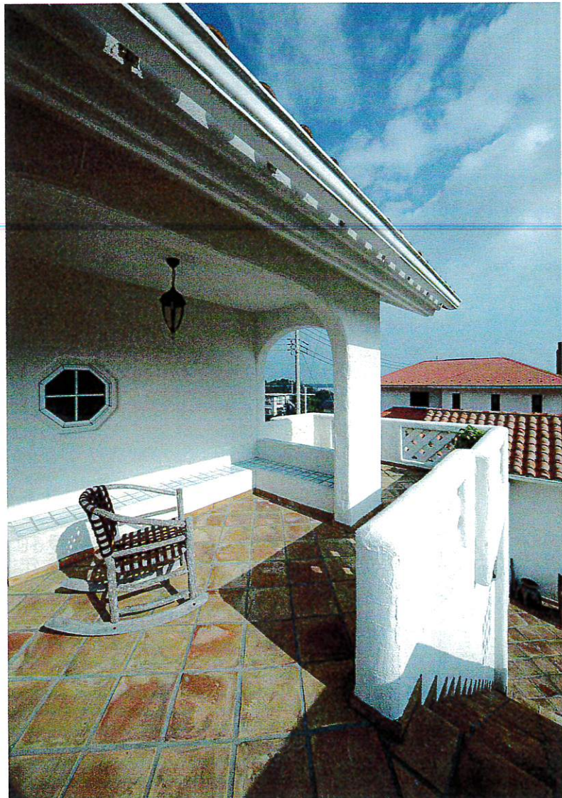
テラコッタタイルを敷き詰めた2階テラスは眺望が良く、漆喰の白い壁と深い庇が心地よいアウトリビングの趣き。角形の窓やブルーのタイルを張ったベンチをL字型に配置するなど細かい造作が施されている
